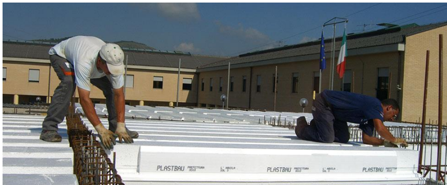
Figura 6. Esempio di posa in opera del solaio
