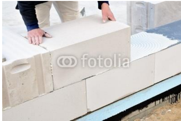
Figura 11. Esempio di posa in opera di muratura perimetrale
