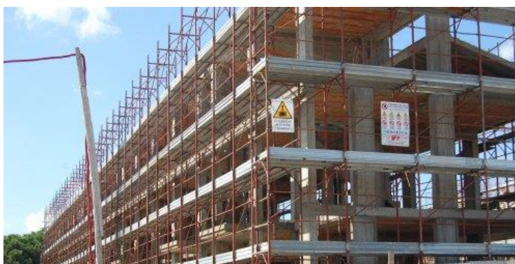
Figura 3. Esempio di posa in opera di strutture in elevazione
