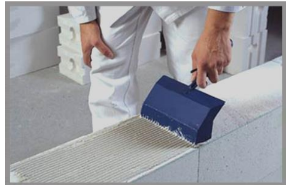
Figura 10. Conco in gasbeton ed esempio di montaggio di muratura
