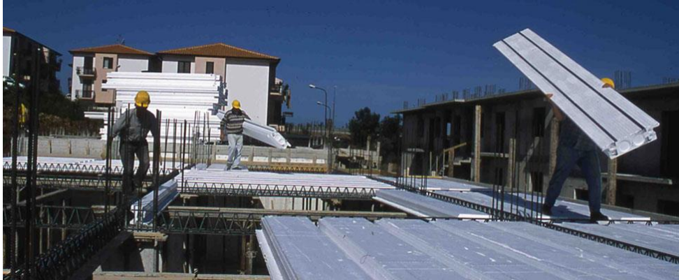
Figura 5. Esempio di posa in opera del solaio
